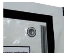
Doucheslang doorgang met scheurbescherming
