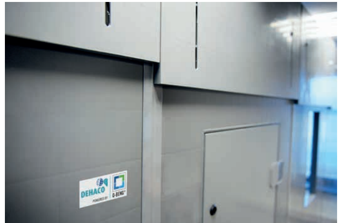
Q-BENG elementen zijn in hoogte verstelbaar tot 270 cm.
